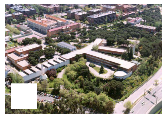
Vista aérea del Instituto de Ciencias de la Construcción Eduardo Torroja.
